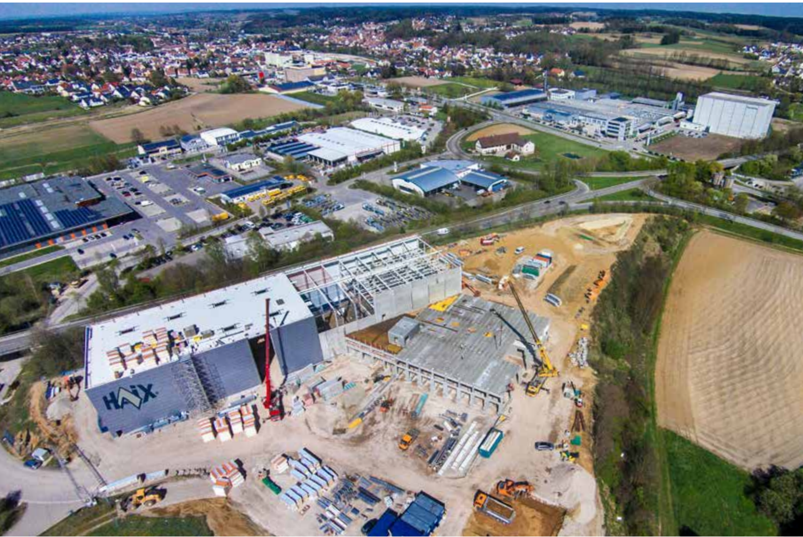
HAIX-Baustelle aus der Drohnenperspektive / From high above
